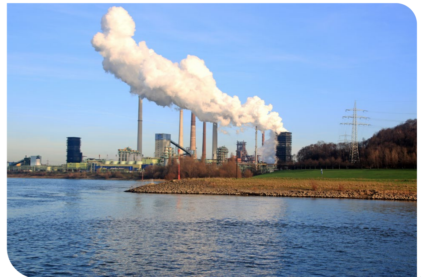
Site industriel à Duisburg (Allemagne)
