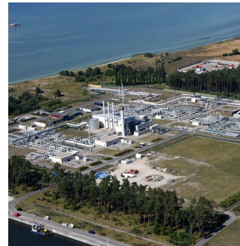
Le site de Lubmin, en Allemagne, station d'arrivée des gazoducs Nordstreams 1 & 2, symbole d'une politique énergétique longtemps appuyée sur le gaz russe.
