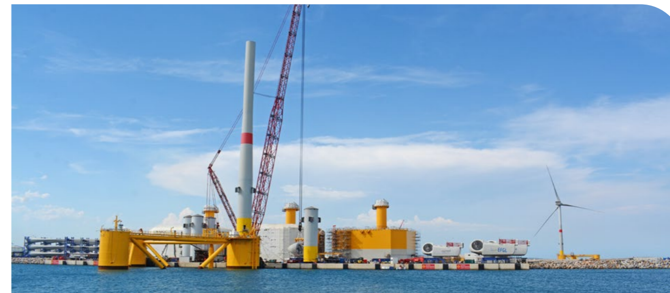
Assemblage d'éoliennes à Port-la-Nouvelle
