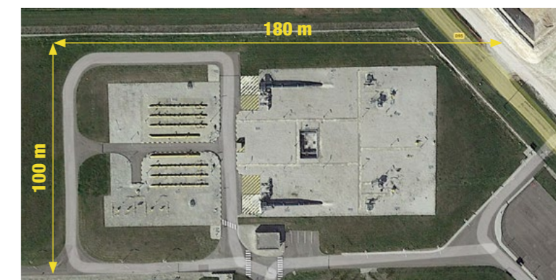
Vue aérienne d'un poste de coupure / comptage / régulation comparable à la future station d'arrivée de BarMar.
